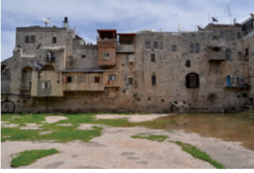
الواجهة الشرقية للبركة، منظر مأخوذ من الغرب
